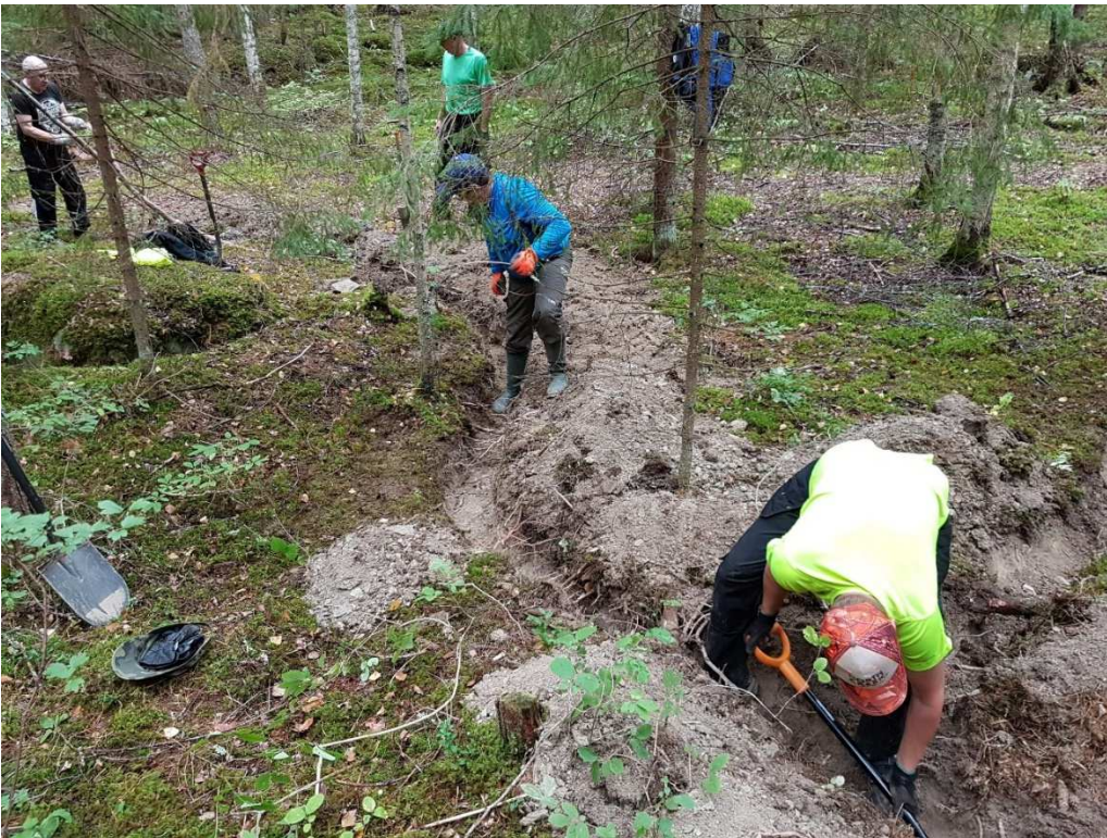
(Maadoitustöitä Niihamassa. Kuva JVH.)
